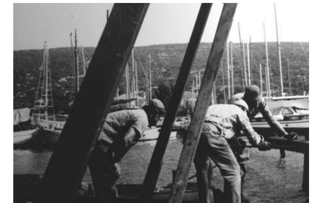
1974. Pobijanje konstrukcije za gatove Pile driving for the construction of piers
